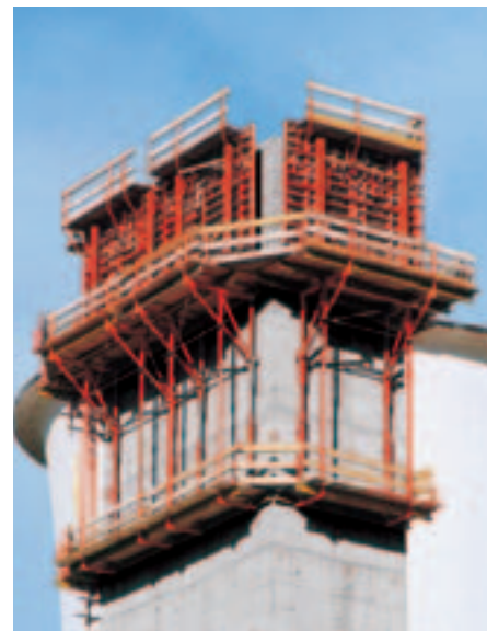
Toimistorakennus CB 240 yhdessä TRIO:n kanssa.
