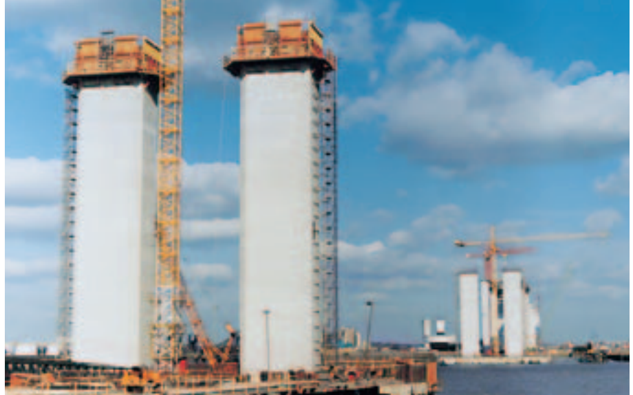
CB 240 yhdessä VARIO GT 24:n kanssa sillan pilareissa.
