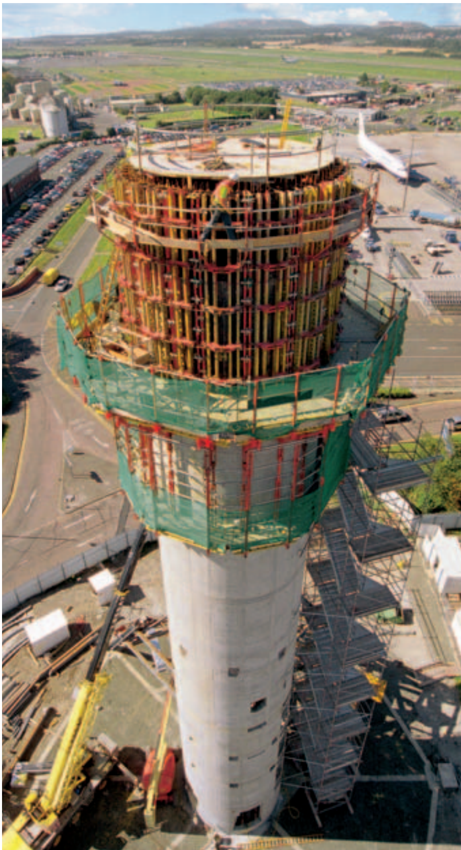
Lennonjohtotorni 46 m korkea, halkaisija 6,85 m. RUNDFLEX ja CB 240 -konsolit.
