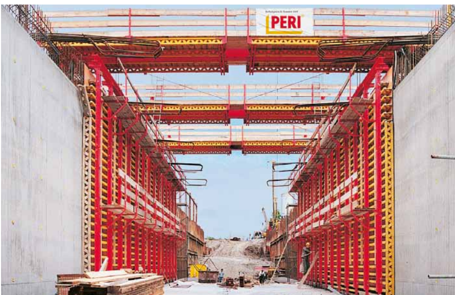
B 311 tunneli Ertingenissä, Saksassa.
