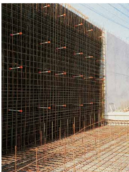
Tunneli Häggsviksledenissä, Ruotsissa.
