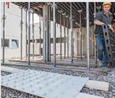
3. Aseta uusi muottilevy valmiiksi.
