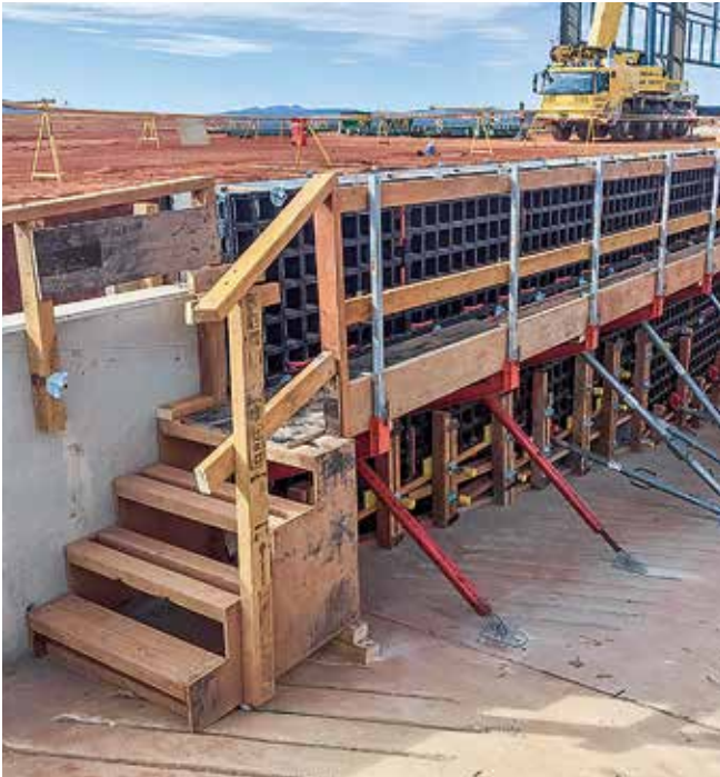
DUOn käyttö mahdollisti huomattavan parannuksen tehokkuudessa rakennustyömaalla.
