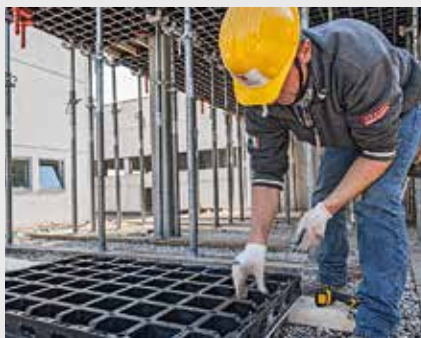
4. Kiinnitä ruuvit ja aseta DUO-kehys uuden levyn päälle.
