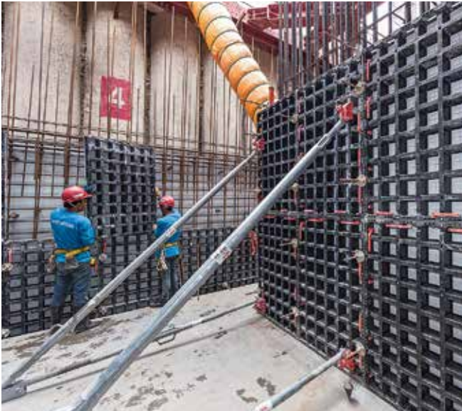
Kevyt paino ja muotituselementtien pieni koko – DUO osoitti etunsa kellarin seinissä.
