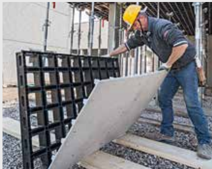
2. Poista vauruoitunut muottilevy.
