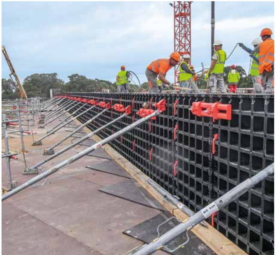
Pienen elementtikokonsa sekä kevyen painonsa ansiosta DUO on omiaan perustuksissa.
