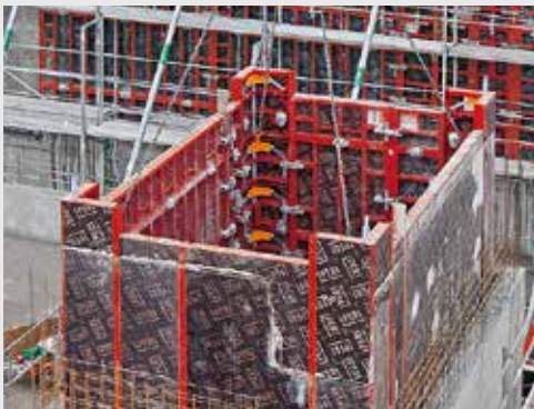
Nosturilla nostettaessa syntyy 35 mm:n rako muottin joka sivulle.
