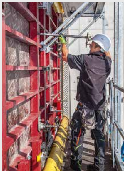
Kaikkiin sidontapaikkoihin on helppo pääsy, ja keltainen kumireuna suojaa elementtejä lialta.
